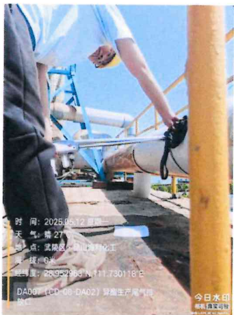
有组织废气: DA007 (CD-08-DA02) 异酯生产尾气排放口
